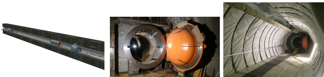
Figuur 31 Installatie voor energieopslag met gecomprimeerde lucht (bron: alacaes)
