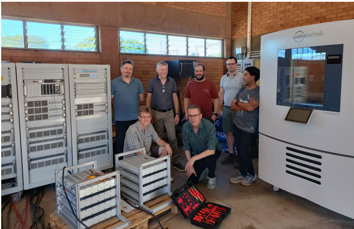
Figuur 25: Oplevering ultracapaciteitsmodules (op voorgrond) door VITO (bron: VITO)
