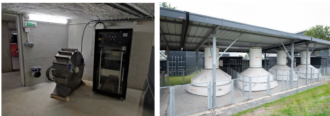
Figuur 27 links: Vlieg wiel energieopslagsysteem ( bron : OXTO Energy ); rechts: hybride systeem met vliegwielen op de voorgrond en gecontaineriseerde batterijopslagsystemen erachter ( bron: Leclanché ).
