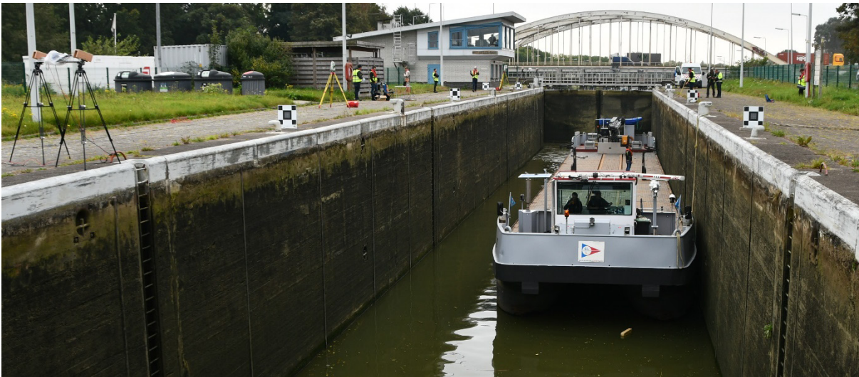
Figuur 16 – Overzicht opstelling
