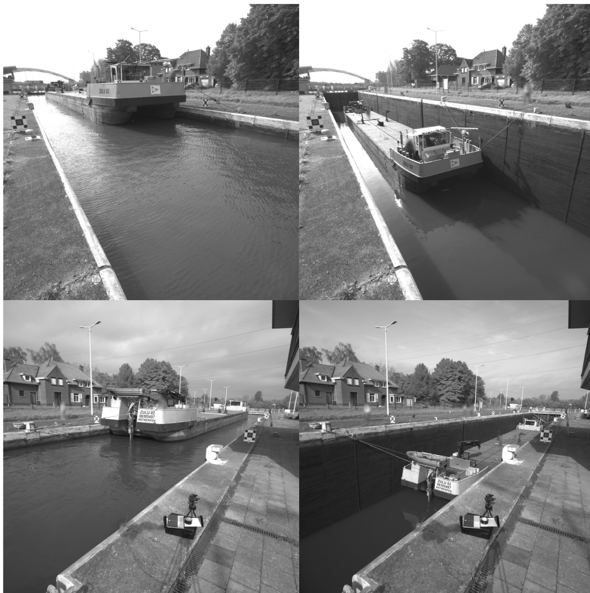
links: hoog water in sluisolk, rechts: laag water in sluisolk; boven: beeld van het stereopaar ter plaatse van boeg van het schip; onder: beeld van het stereopaar ter plaatse van het hek van het schip
